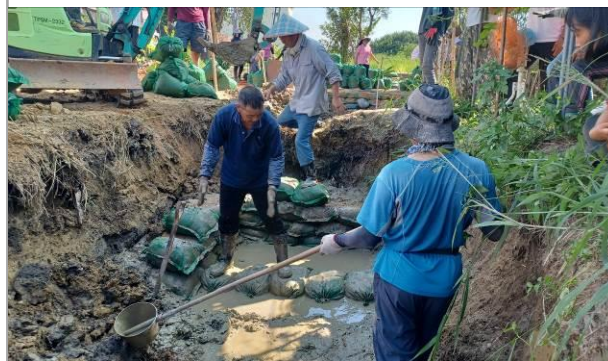
礫間淨化池施工
