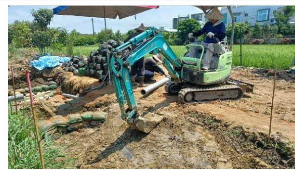
水生植物池施工
