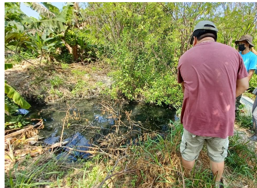
沉澱池淤積嚴重，缺乏安全設計
