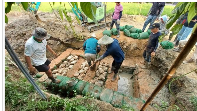
礫間淨化池施工
