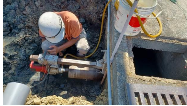
↑ 施工中，在靠近沉澱池附近設置新的入水口重新洗洞，右圖為新的入水口。
