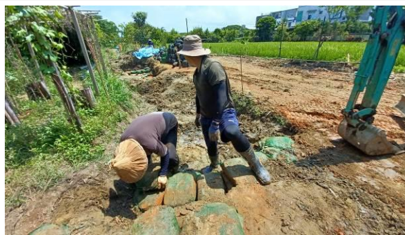
水生植物池施工
