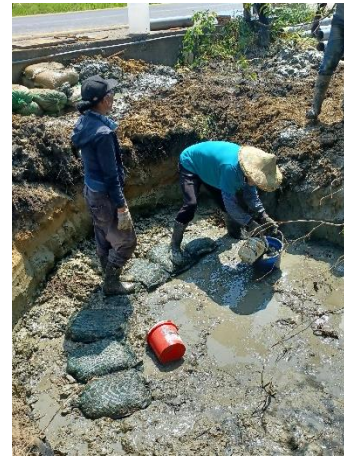
↑ 施工中，沉澱池旁堆放土包袋鞏固池岸，並設置維護管理階梯方便日後維護管理
