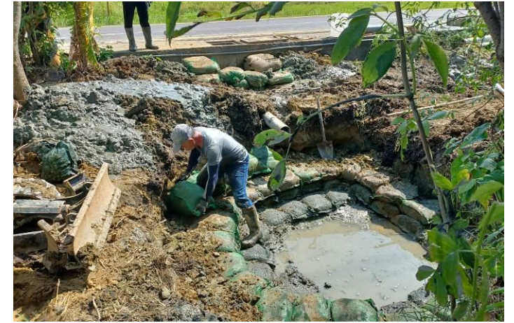
↑ 施工中，沉澱池旁堆放土包袋鞏固池岸，並設置維護管理階梯方便日後維護管理
