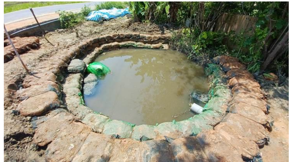
↑ 沉澱池完工狀況，以土包袋鞏固池岸，可避免池岸崩塌影響使用
