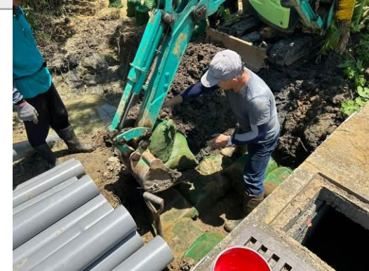
↑ 施工中，入水口後堆放土包袋施做攔汙池，讓垃圾在攔汙池先攔下
