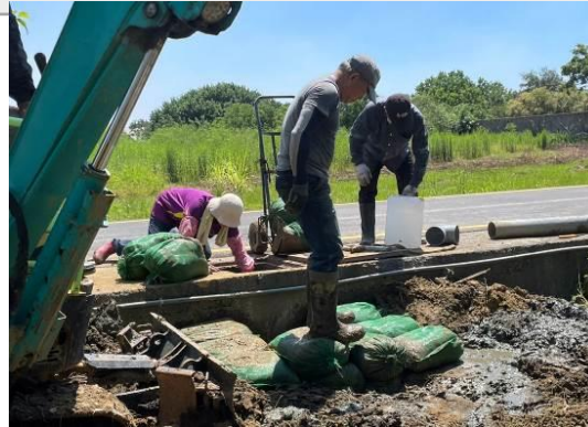
↑ 施工中，入水口後堆放土包袋施做攔汙池，讓垃圾在攔汙池先攔下
