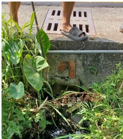
入水口破損、無阻擋設施，沉澱池淤積嚴重
