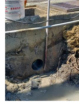
↑ 施工中，在靠近沉澱池附近設置新的入水口重新洗洞，右圖為新的入水口。
